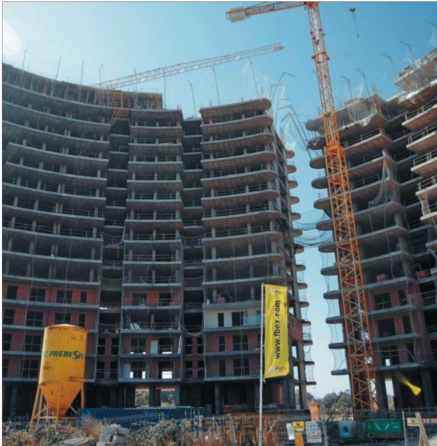
Construcción de viviendas en Sagunto (Valencia). / SANTIAGO CARREGUÍ
