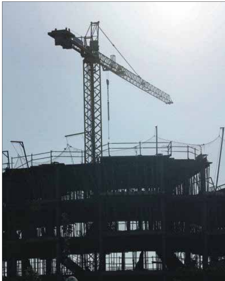
Un edificio a media construcción en el residencial Francisco Hernando, de Seseña (Toledo). /SAMUEL SÁNCHEZ
