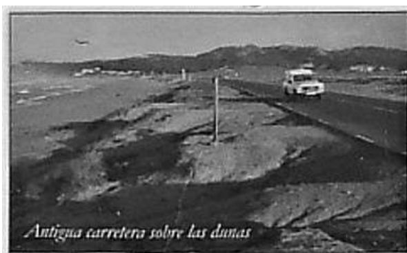
1_Playa de A Lanzada. Estado previo de la carretera sobre el sistema dunar (izda,) y obras de la demolición de la carretera previa a la restauración del sistema dunar (dcha). Proyecto y obra de regeneración ecológica del istmo de A Lanzada, en Pontevedra, Galicia (García, C.; Aguirre, I.; Agrasar F.; 1993-1996-2010). Fuente: Ministerio de Medio Ambiente
