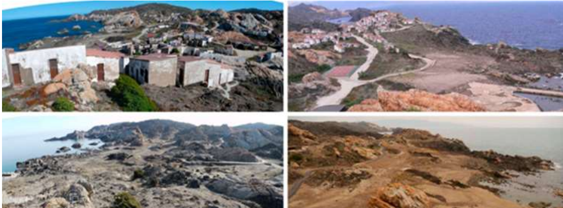
3_Estado previo (arriba) y posterior (abajo) del proyecto y obra de desconstrucción d'ús públic del Paratge de Tudela-Culip (Club Med) al Parc Natural de Cap de Creus. Gerona. EMF M. Franch, Ardèvol Associats (Ardèvol, 2005-2010)
