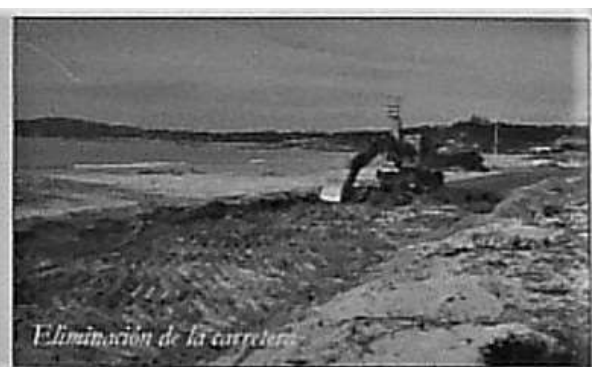
1_Playa de A Lanzada. Estado previo de la carretera sobre el sistema dunar (izda,) y obras de la demolición de la carretera previa a la restauración del sistema dunar (dcha). Proyecto y obra de regeneración ecológica del istmo de A Lanzada, en Pontevedra, Galicia (García, C.; Aguirre, I.; Agrasar F.; 1993-1996-2010). Fuente: Ministerio de Medio Ambiente
