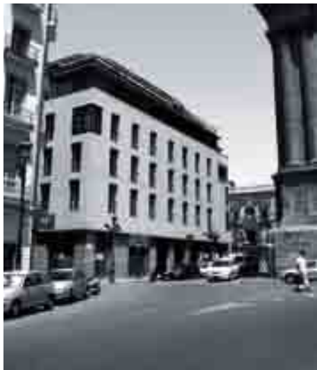
Antes y después de la intervención.
