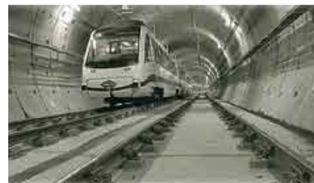
Ampliación del túnel del Metro.
