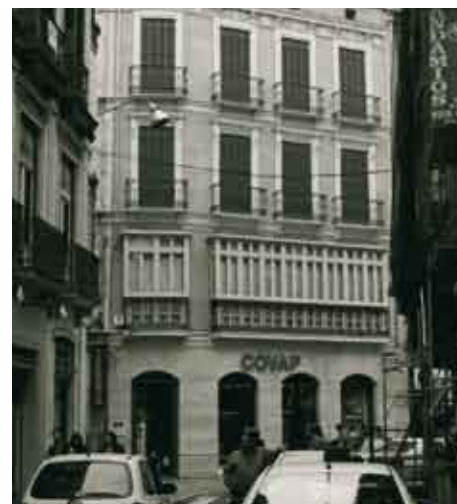
Buen ejemplo de remodelación de huecos en calle Granada, 1999.
