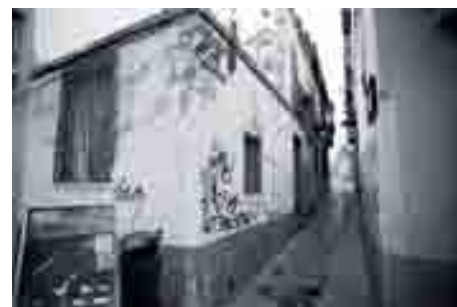
Estado actual de la calle Tomás de Cózar.
