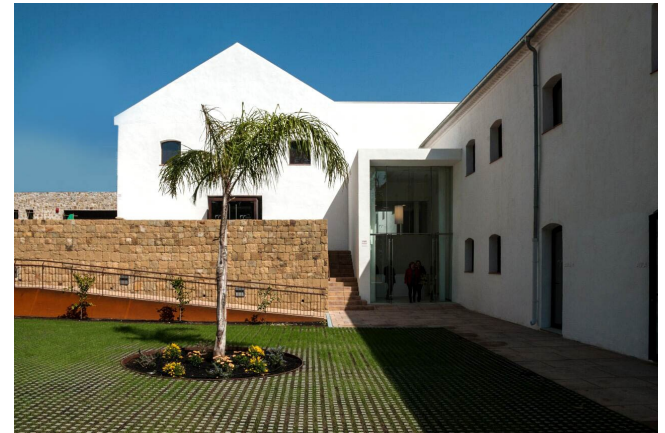
Estado actual del antiguo trapiche de Guadiza, hoy centro cultural
