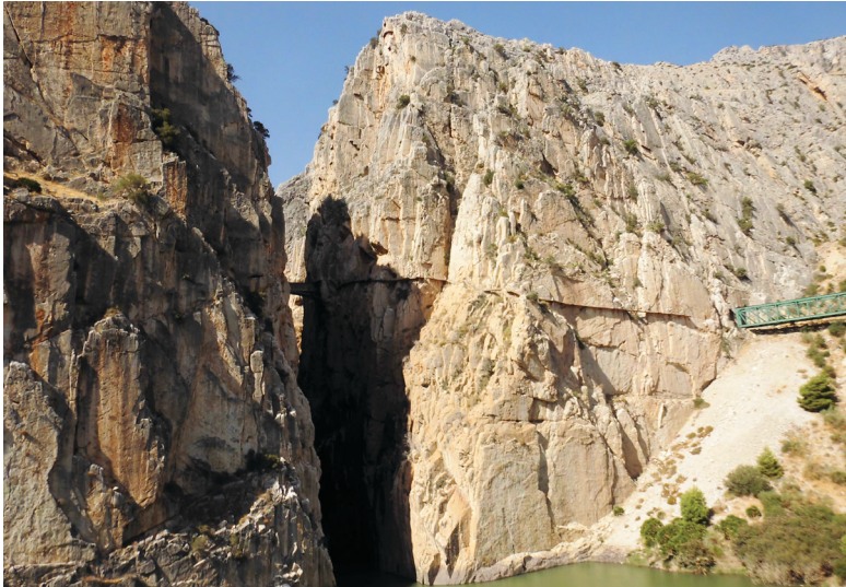
La salida del Caminito del Rey antes de su restauración
