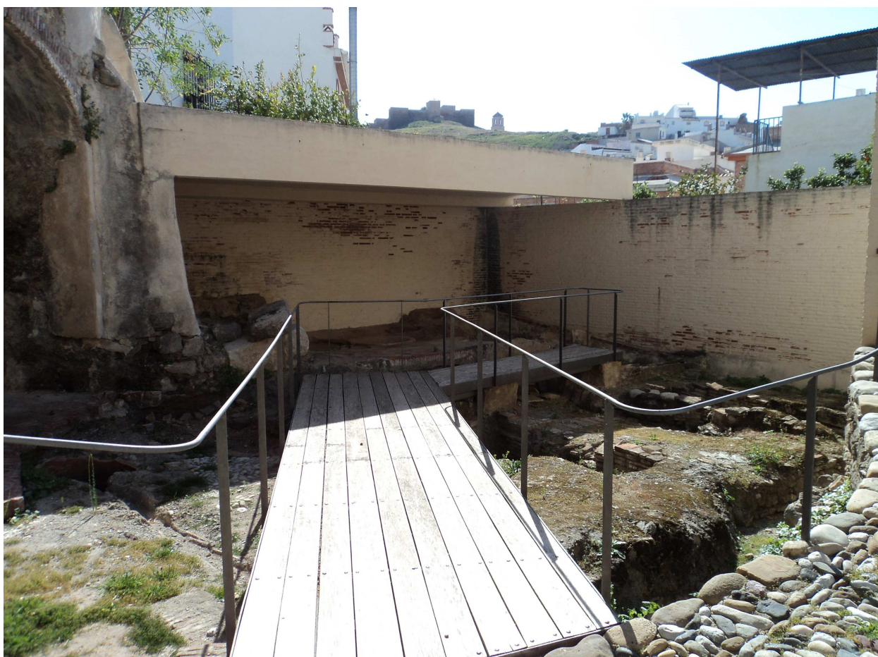
Pasarela que recorre el área de la caldera (izquierda), prensa (fondo) y alpechineras (derecha)
