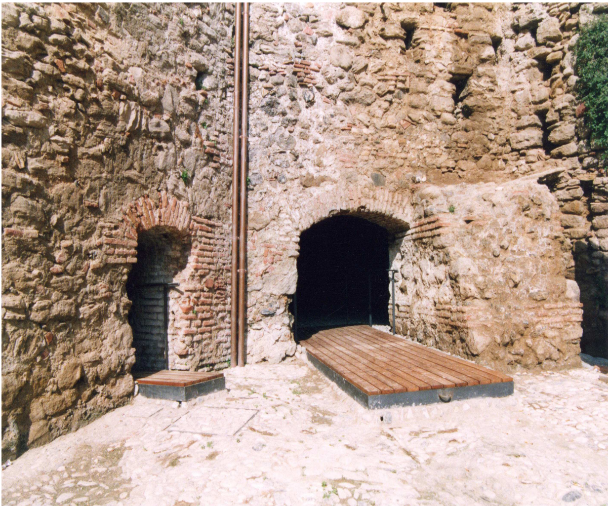
Entrada a salas del aljibe (sala segunda) y molienda (sala tercera)
