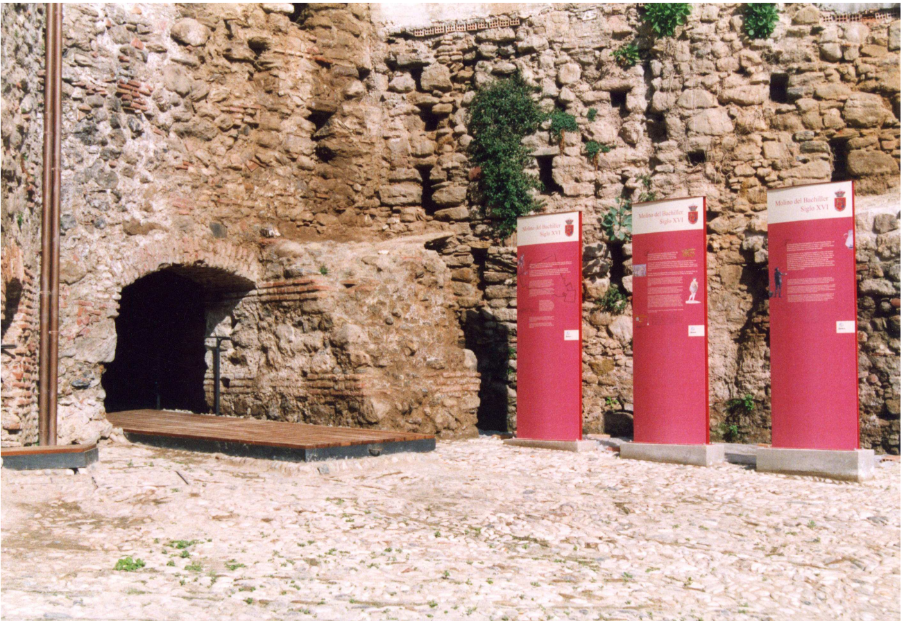
Detalle tras los trabajos de la primera fase de puesta en valor
