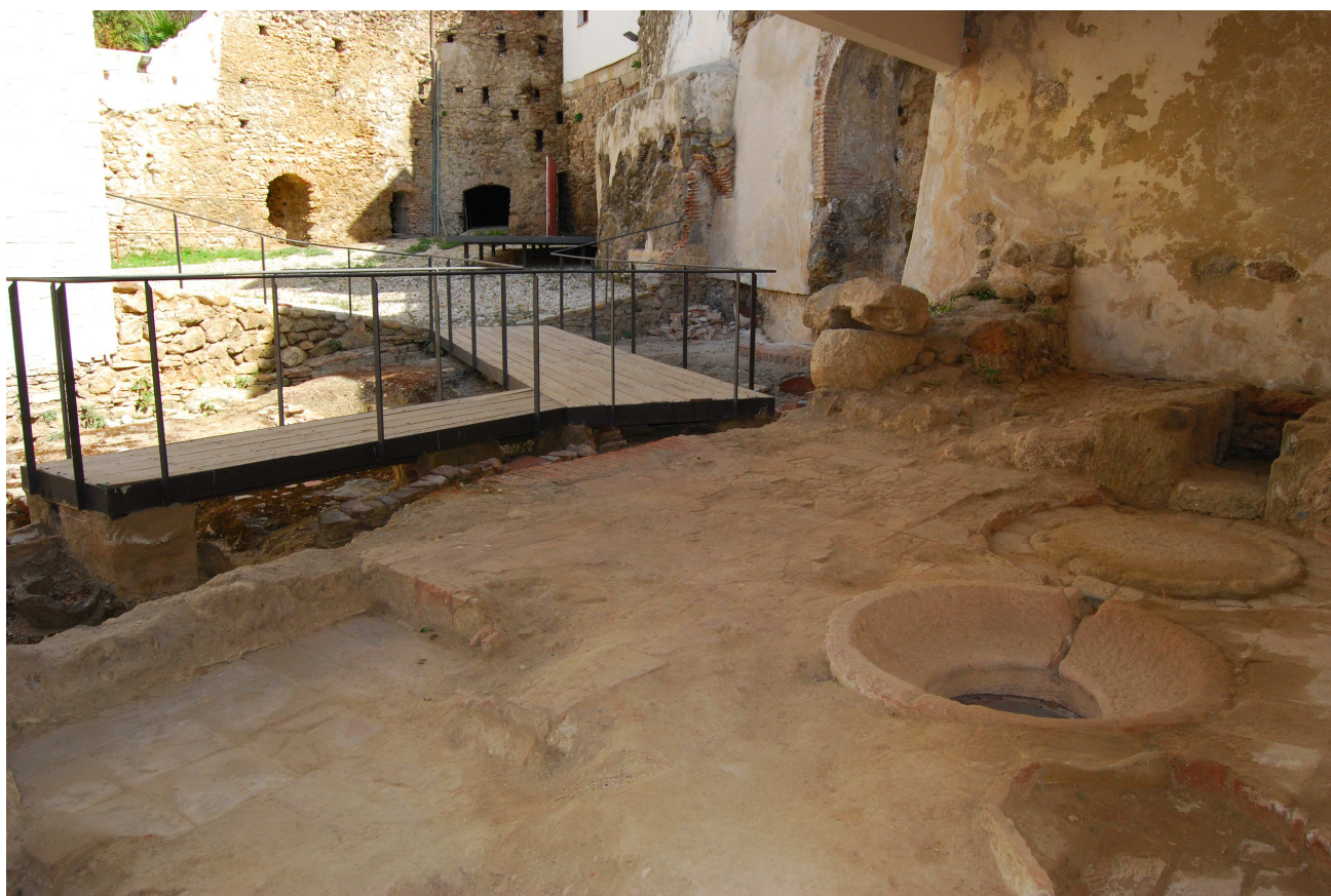
Vista general del molino. Archivo Ayto. Álora
