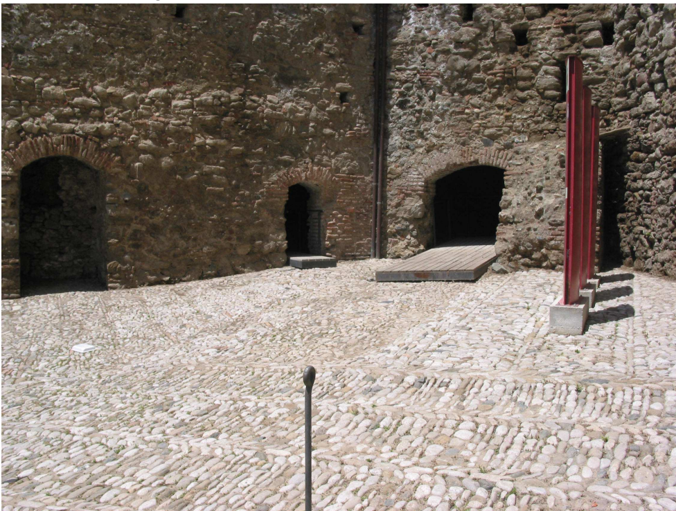
Detalle tras trabajos primera fase
