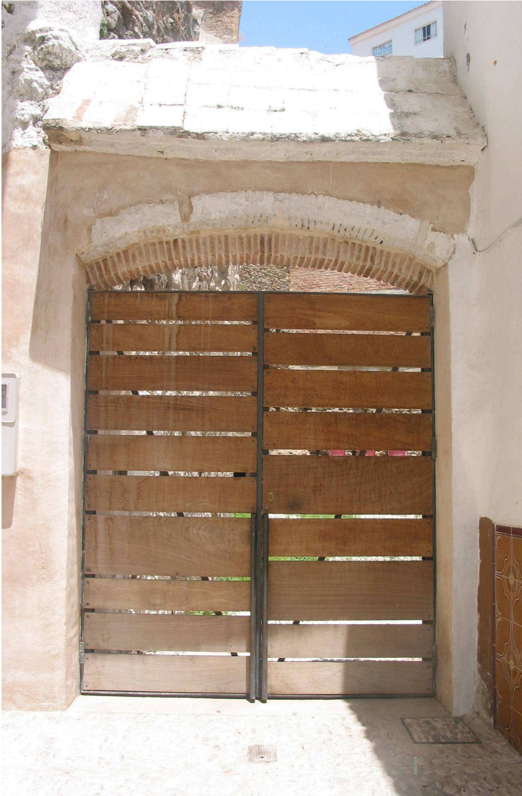
Puerta actual de madera
