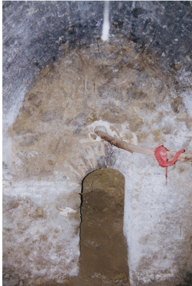
Interior de una de sus salas. Foto Juan Gavilanes
