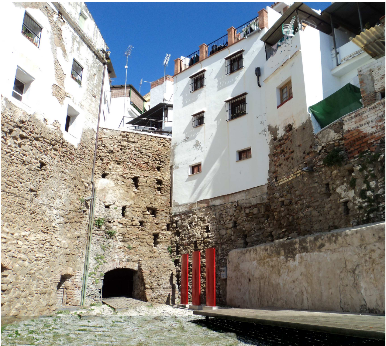
Escenario (incorporado en la última fase de rehabilitación) y muro de mampuesto que se corresponde con C/ Nueva
