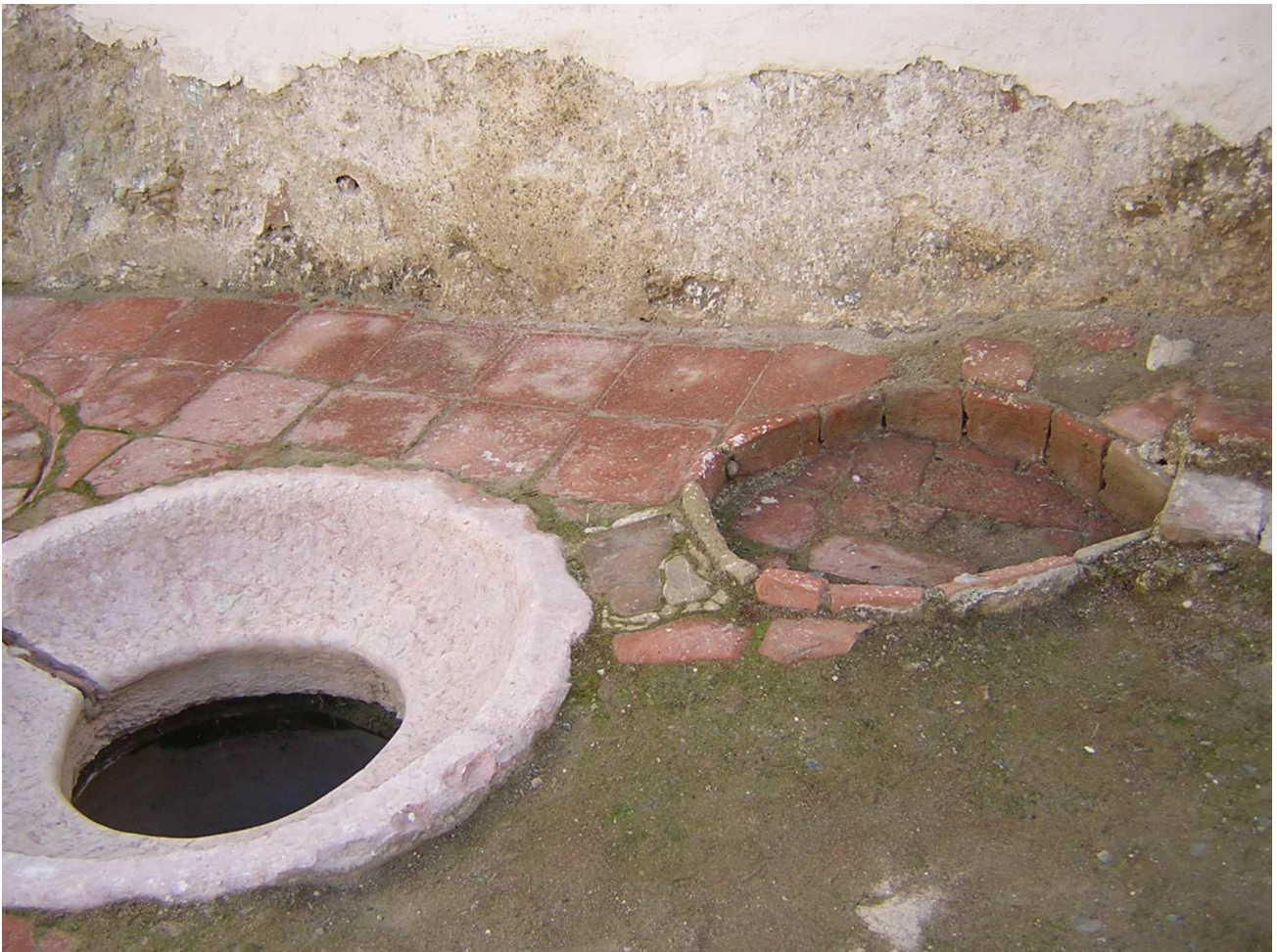
Junto al depósito de prensa, inicio de la canalización hacia las jamileras
