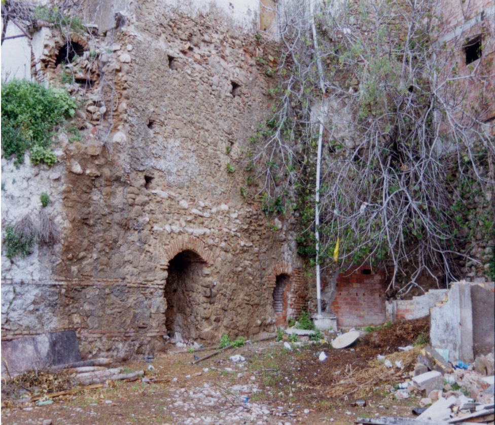
Imagen anterior a rehabilitación. Foto Juan Gavilanes
